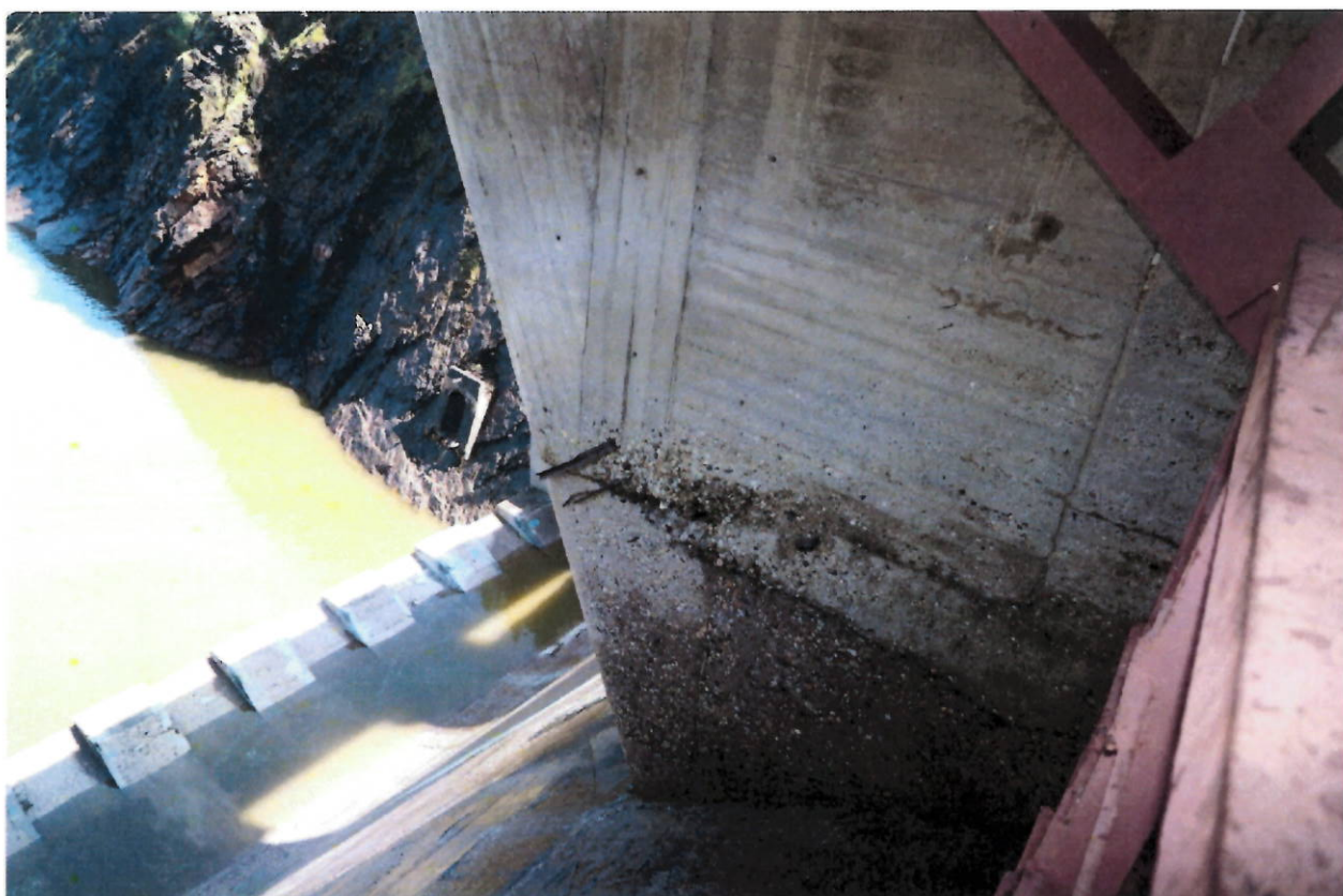
Фото 4. Вид на чашу водослива с гребня плотины, отм. 283,00м.
